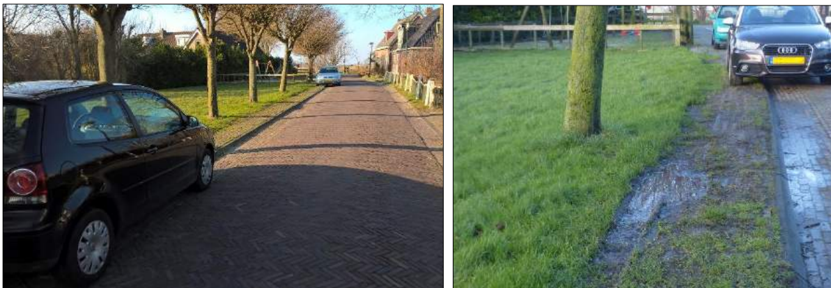
Afbeeldingen: kuilvorming als gevolg van parkeren in de berm van de Vrijterp
